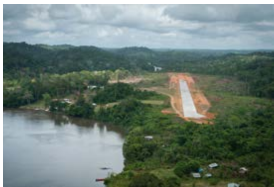
Mise en dur de la piste d'aérodrome de Camopi. © PAG / G.Feuillet Maîtrise d'ouvrage : Conseil général. Montants : 6.000.000€
